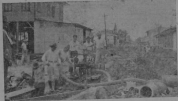
Vista general de los trabajos de sanias y colocación de tuberías, que se practican en el final de la calle Sa. Sur.
