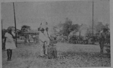
Don Juanito Romagosa (D) y Mr. Harman (I), delegado del Gobierno y uno de los Directores de los trabajos de pavimentación, respectivamente, inspeccionando esas obras.
