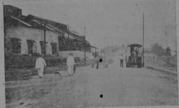
Vista general de la calle que conduce al Hospital, cuya pavimentación está al terminarse.
