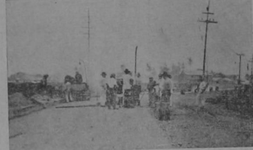
Aspecto de una calle terminada de pavimentar. Puede verse la máquina esparcedora de asfalto.
